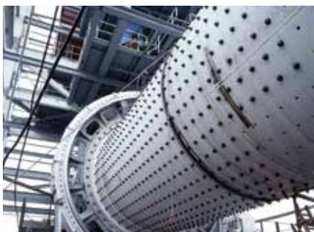
Rohrmühle in der Zementindustrie
