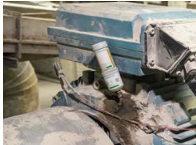
Solución de lubricación Cemento: OPTIME C1 lubrica con precisión milimétrica e indica, gracias a la tecnología inteligente, su estado en un terminal (móvil), independientemente de la ubicación.
