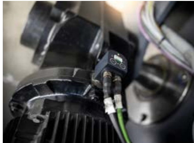
Solución de Condition Monitoring Centro logístico: SmartCheck monitoriza los motores de los transelevadores
