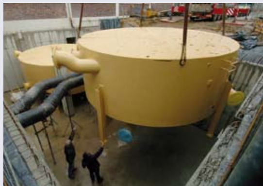
冷却装置的核心: 两个大冷却剂池, 每个容量60立方米
