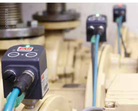
Nadzor črpalke s FAG SmartCheck
