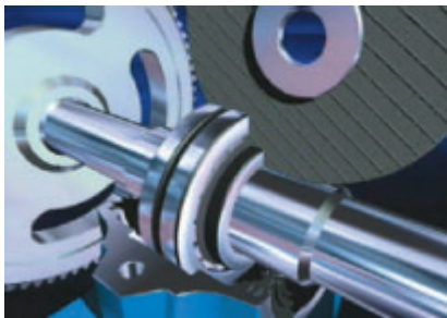
3 Irrota vanha laakeri (jakamaton kiristysholkkikiinnitteinen laakeri irrotetaan leikkaamalla laakeri ja kiristysholkki katkaisulaikalla)
