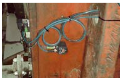
Systémy FAG SmartCheck sledují stav čepového ložiska na straně pohonu
