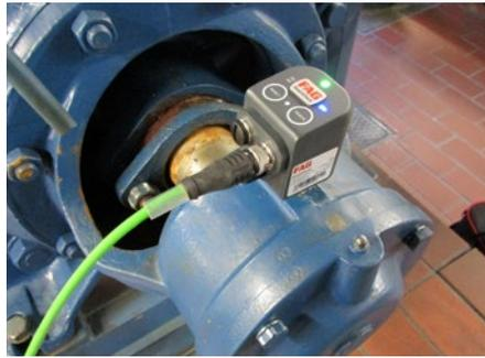
FAG SmartQB Sensoren überwachen den Zustand der Pumpen am Aggregat
