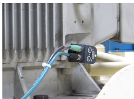
FAG SmartCheck installé à la base du moteur d'entraînement
