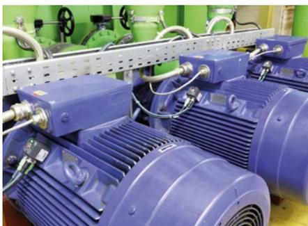
Elektromotorenüberwachung mit dem FAG SmartCheck
