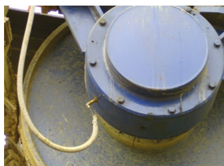
Le point de lubrification du roulement sur un tambour du convoyeur
