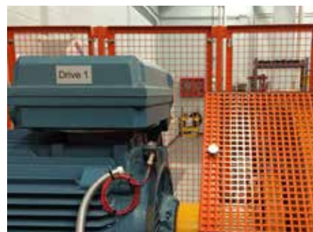
Surveillance des vibrations du moteur par le FAG SmartCheck
