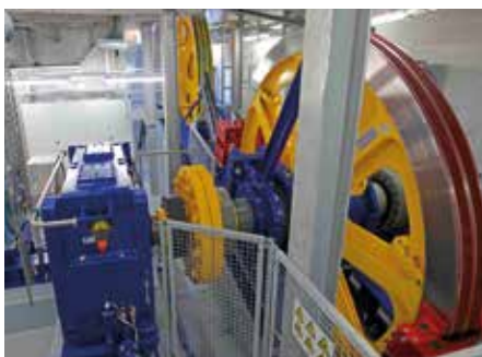
Transmission dans l'une des deux gares d'altitude.
