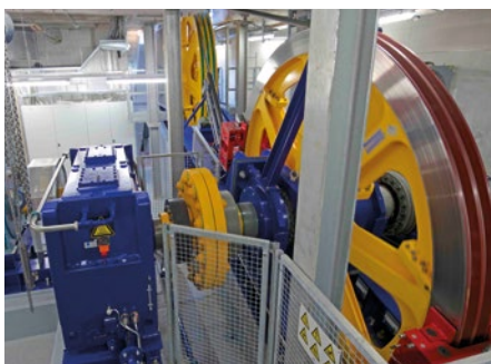
Antriebsstrang in einer der beiden Bergstationen
