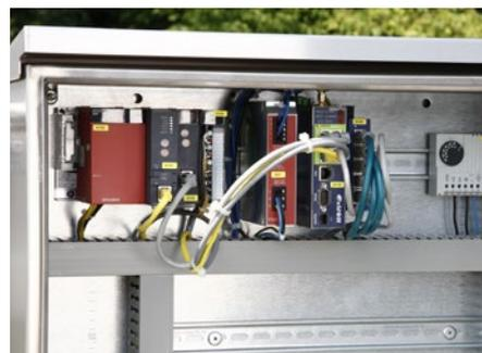
Armoire électrique : MELSEC System Q et router eWon
