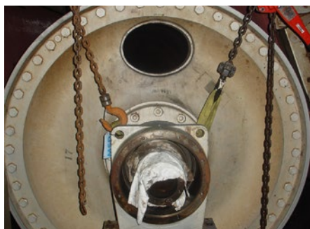
Демонтаж подшипников сушильного цилиндра.
