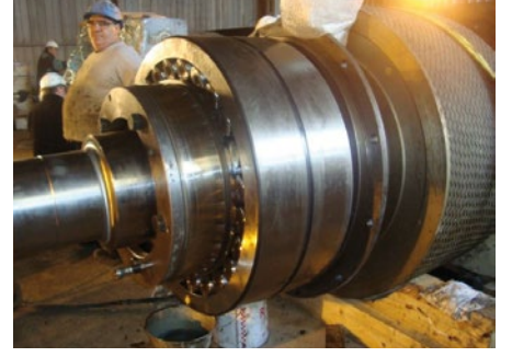
Yeni rulmanların montajı
