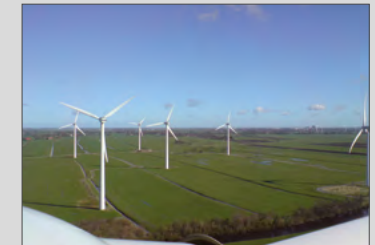
Ante la dificultad de acceder a los aerogeneradores, la monitorización remota resulta especialmente útil
