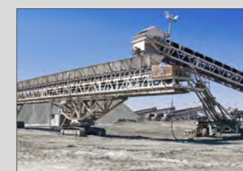
Una parada no planificada de la cinta transportadora supone elevados costes
