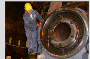
Trabajos de montaje en el soporte
