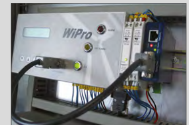
Sistema de monitorización online FAG WiPro
