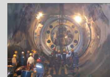
Tuneladora (TBM) en funcionamiento
