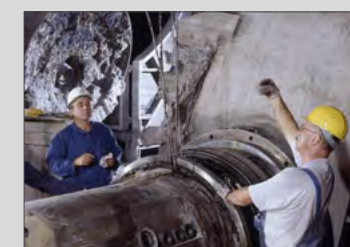
Montadores trabajando in situ
