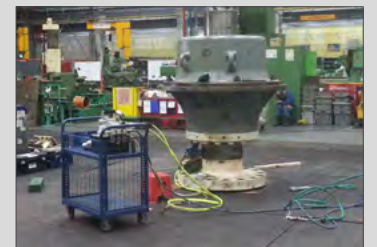
Trabajos de montaje in situ; en la imagen unidad de eje y soporte
