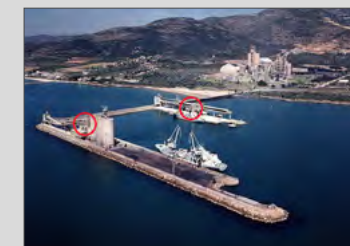
Cinta transportadora en el puerto
