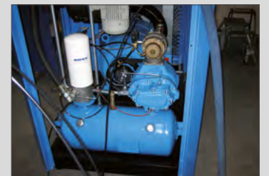
Monitorización de un compresor de hélice de la empresa Boge
