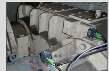
Monitorización del motor y el engranaje mediante FAG SmartCheck
