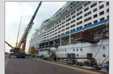
Renovación general en el dique seco
