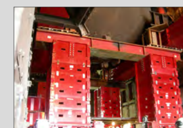
Estructura de soporte del recipiente
