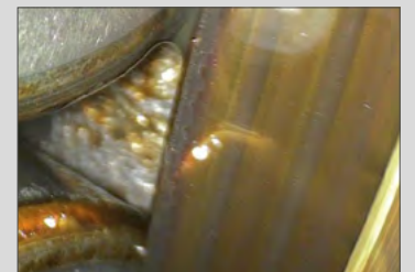
Daños en la pista de rodadura del anillo interior
