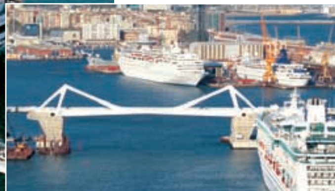
Barcelona. Atualmente, a maior ponte basculante dupla do mundo bascula sobre rótulas de grandes dimensões, livres de manutenção, com 670 mm de diâmetro do orifício.
