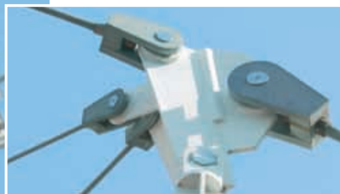
Filigrana e, mesmo assim, suportando uma carga enorme: Ligação dos cabos tensores da estrutura da cobertura
