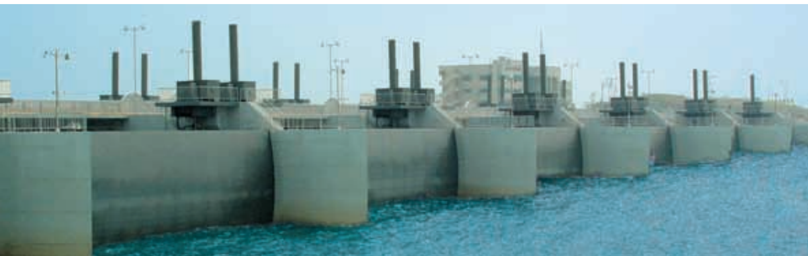
Aterro hidráulico na Coreia – Saemangum: a barragem concluída em 2001 é um projeto-modelo e, ao mesmo tempo, um dos mais interessantes casos de aplicação dos produtos ELGES
