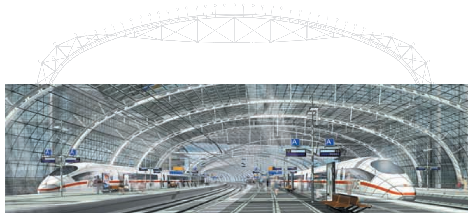
Estação ferroviária de Lehrter, Berlim: A cobertura da maior estação ferroviária da Europa tem uma envergadura de aprox. 300 metros sobre as plataformas, integrando numerosas rótulas e sistemas de pinos da ELGES. (Figura: Computersimulation © Archimation, Berlim)
