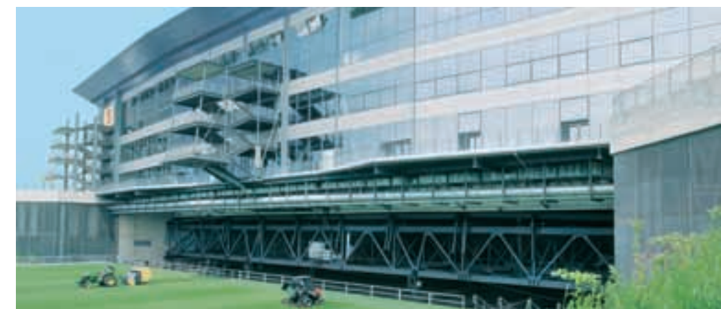
Estádio "AufSchalke" en Gelsenkirchen: el terreno de juego, que aquí aparece frente al estadio, tarda seis horas en recorrer los 300 metros hasta la parte interior del estadio
