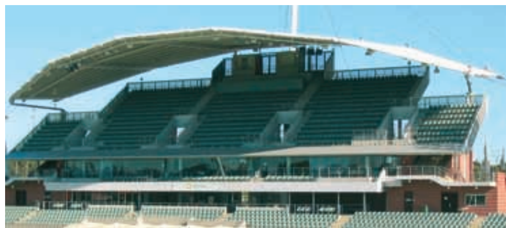
State Hockey Centre Sydney: todos os pontos de junção dos cabos no beiral do teto e nos postes estão apoiados em rótulas revestidas de ELGOGLIDE®.
