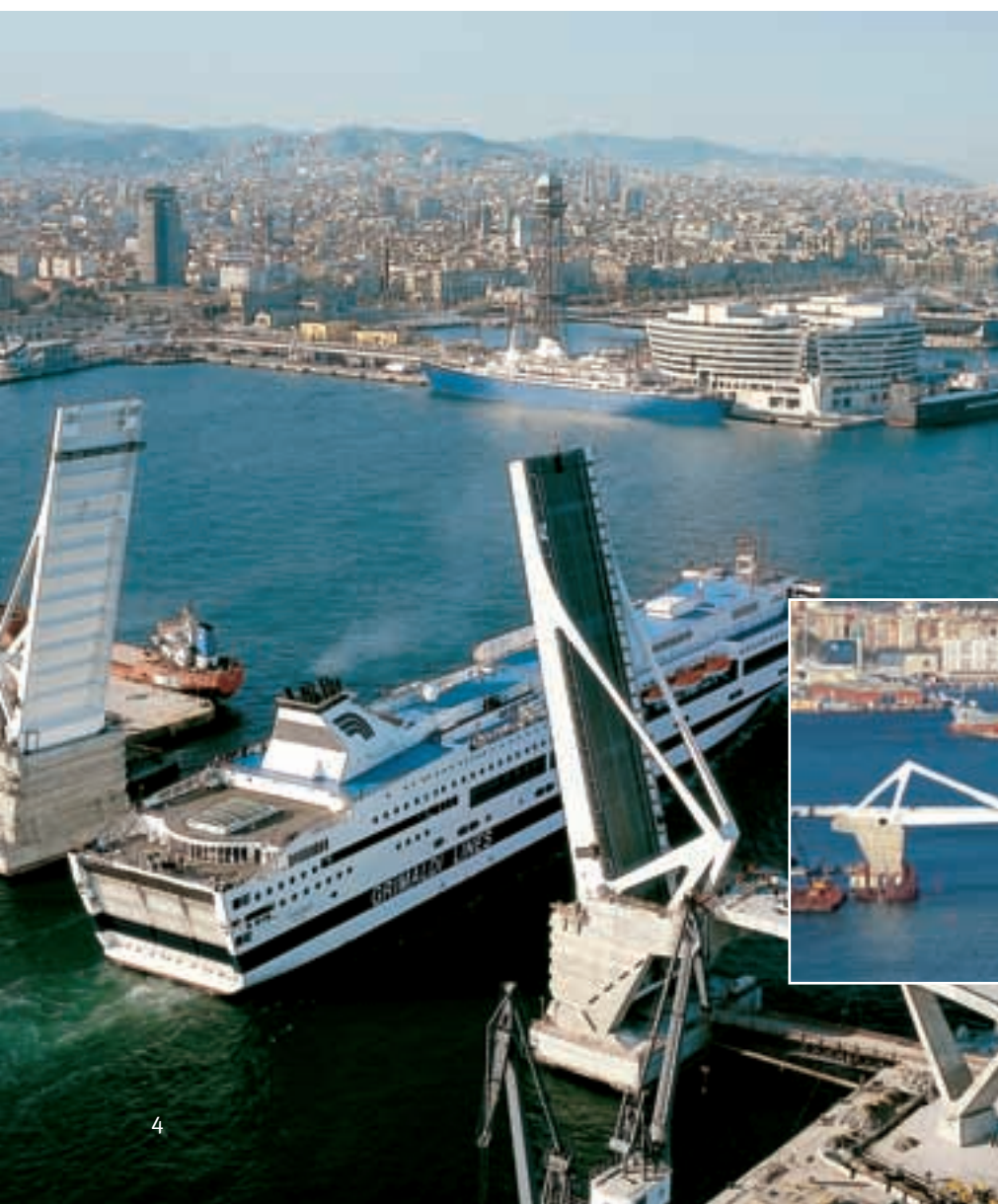
Barcelona. Atualmente, a maior ponte basculante dupla do mundo bascula sobre rótulas de grandes dimensões, livres de manutenção, com 670 mm de diâmetro do orifício.
